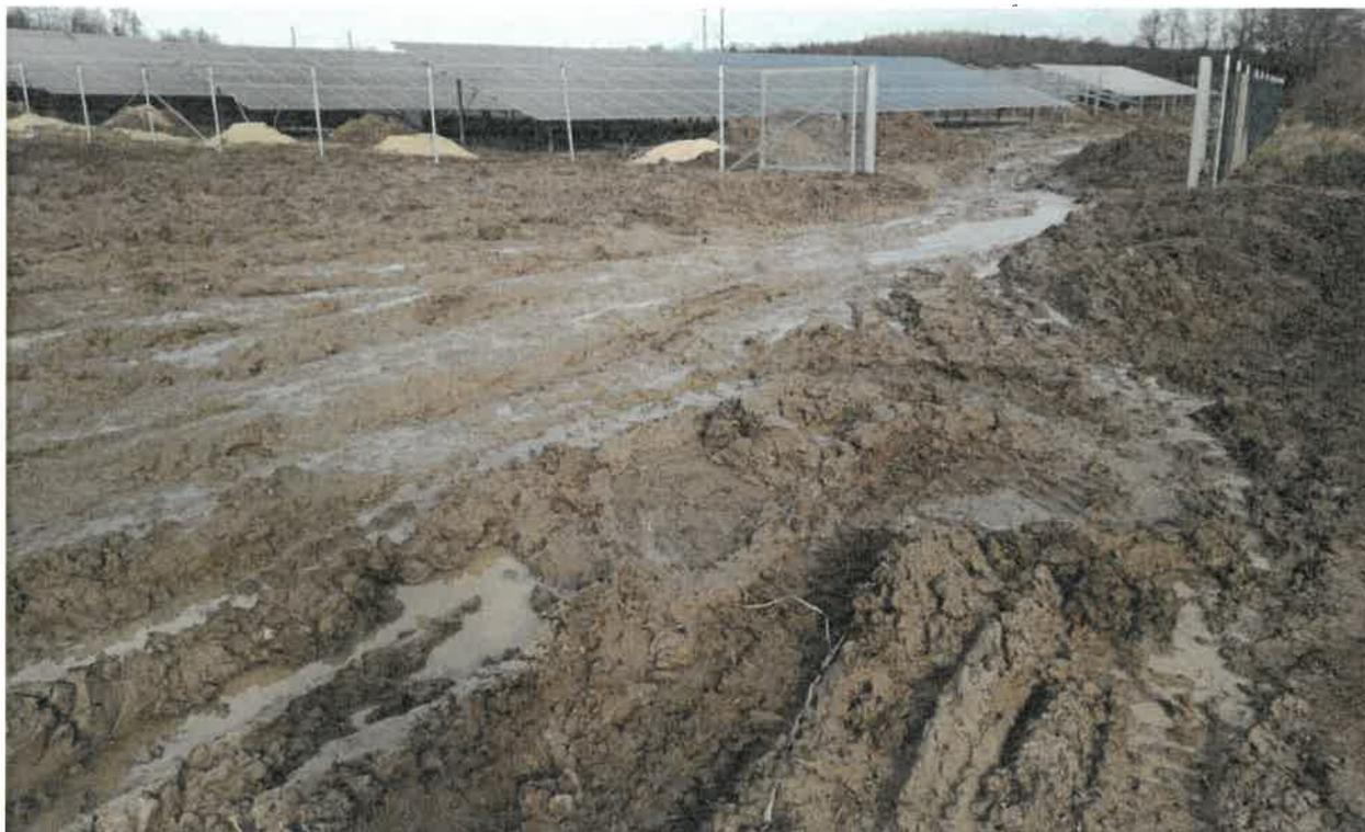
**Foto 1: Befahrung ungeschützten Oberbodens bei ungeeigneter Witterung/Bodenfeuchte führt zu Schädigung des Bodengefüges und schränkt die Funktionsfähigkeit des Bodens ein**
