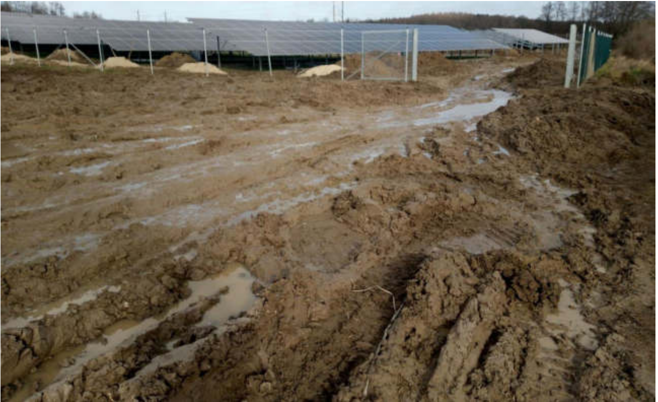
Foto 1-3: Befahrung ungeschützten Oberbodens bei ungeeigneter Witterung/Bodenfeuchte führt zu Schädigung des Bodengefüges und schränkt die Funktionsfähigkeit des Bodens ein
