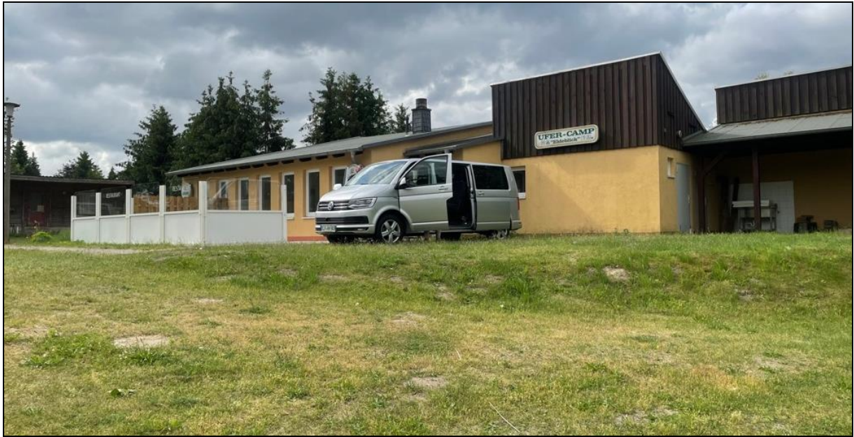
Abbildung 1: Gaststätte mit integriertem Sanitärbereich des Wasserwanderrastplatzes „Ufercamp-Eldeblick“
